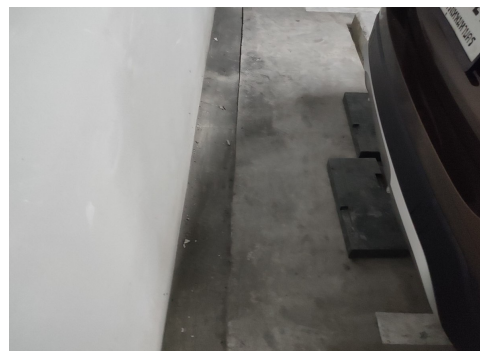
ภาพที่ 5-13 รางระบายน้ำรอบโครงการ ไม่พบว่ามียตะกอนอุดตัน
