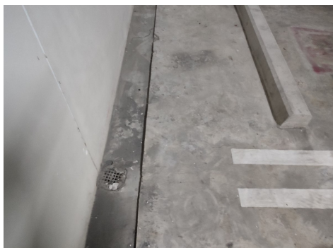
ภาพที่ 5-13 รางระบายน้ำรอบโครงการ ไม่พบว่ามียตะกอนอุดตัน
