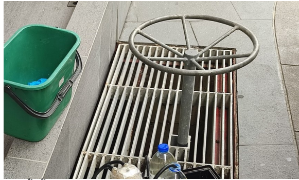
ภาพที่ 5-14 บ่อพักน้ำที่มีตะแกรงดักขยะ และ Stop Log ไม่มีขยะอุดตันสามารถระบายน้ำได้ดี
