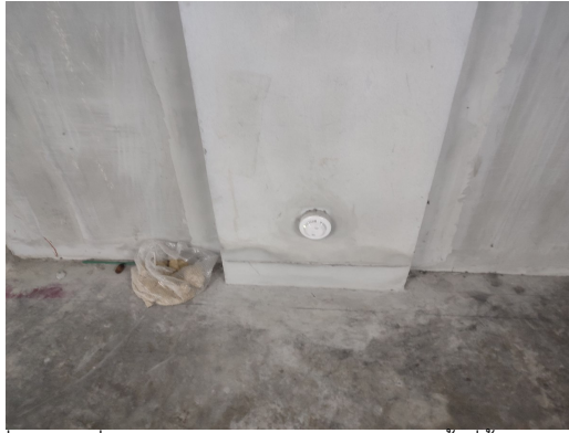
ภาพที่ 5-29 เครื่องตรวจจับก๊าซ LPG และ NGV ติดตั้งที่ชั้นจอดรถใต้ดิน
